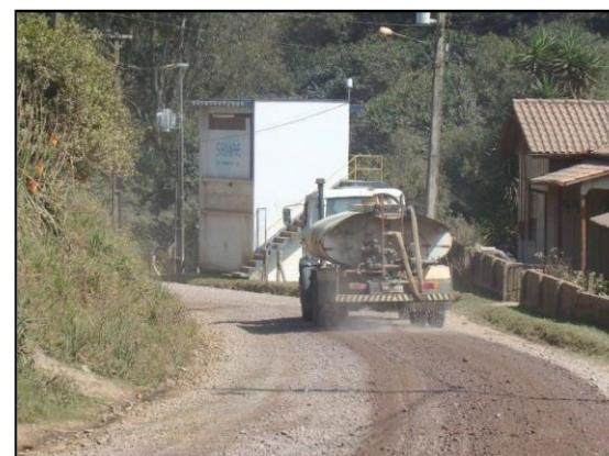
Figura 58. Caminhão-pipa molhando via para diminuir a suspensão de material particulado (poeira).
