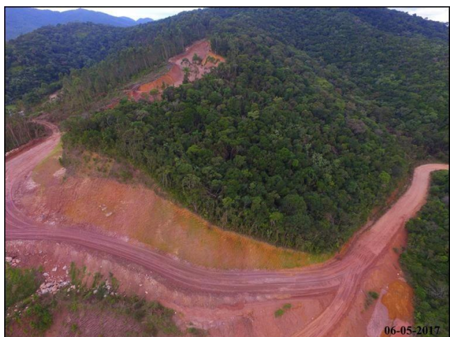
Figura 8. Fotografia aérea da lateral noroeste da Área 01.
