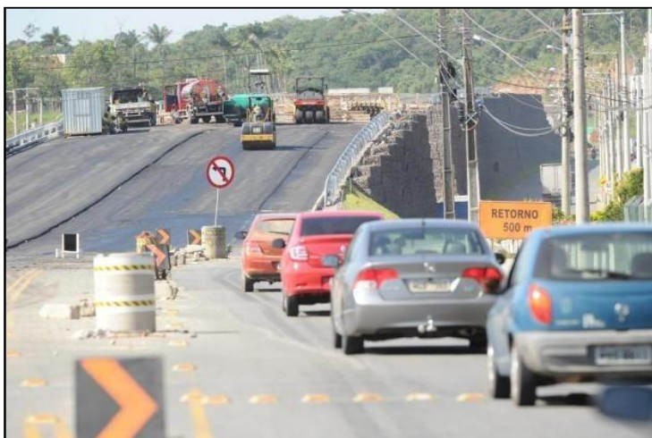
Figura 59. Trecho da Rodovia Antônio Heil em obras, próximo a área do empreendimento.
