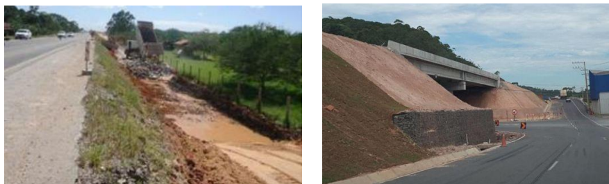
Figura 9. Obras de ampliação da Rodovia Antônio Heil (Secretaria de Estado de Infraestrutura/2018).
