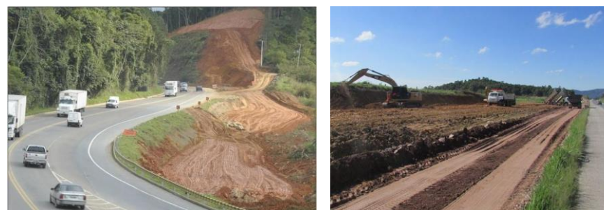
Figura 11. Obras de Duplicação da BR-470. Demanda crescente da obra por materiais de empréstimo, como saibro e argila, para nivelamento do solo e fundação.
