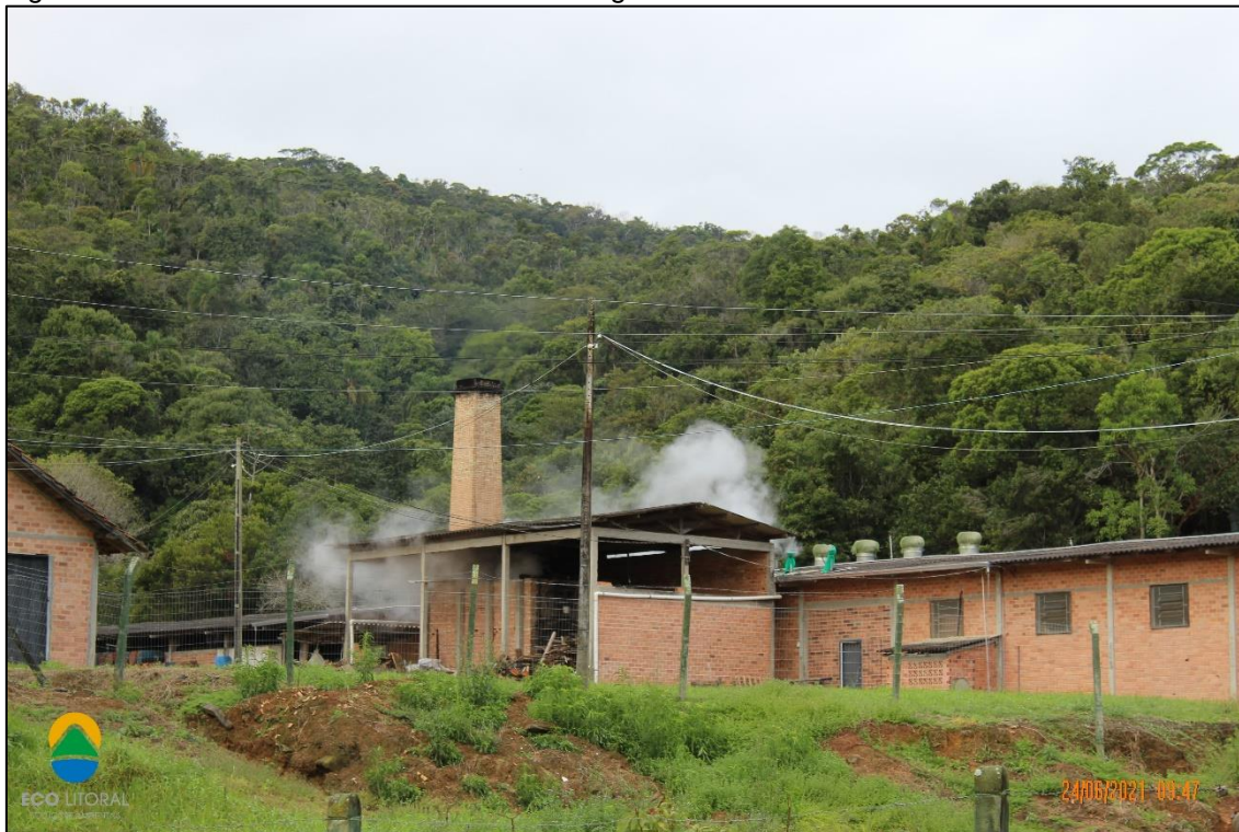
Figura 148 - Atividade de olaria realizada na região.
