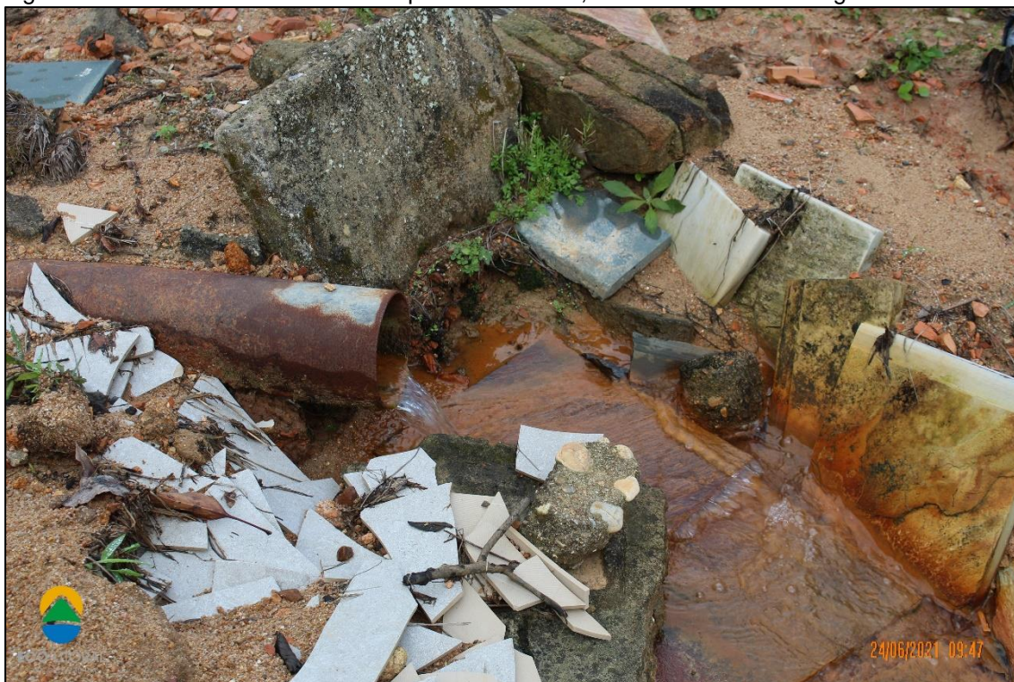
Figura 151 - Curso hídrico canalizado presente na AID, com resíduo e APP degradada.
