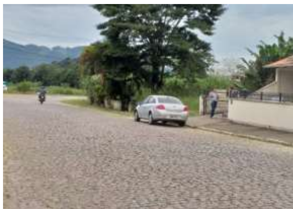
Foto 10.1-81: Estrutura Viária em Glória, Município de Rodeio.
