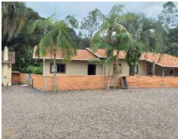
Foto 10.1-64: Unidade habitacional localizada no Bairro Cobras, Município Rio do Sul.
