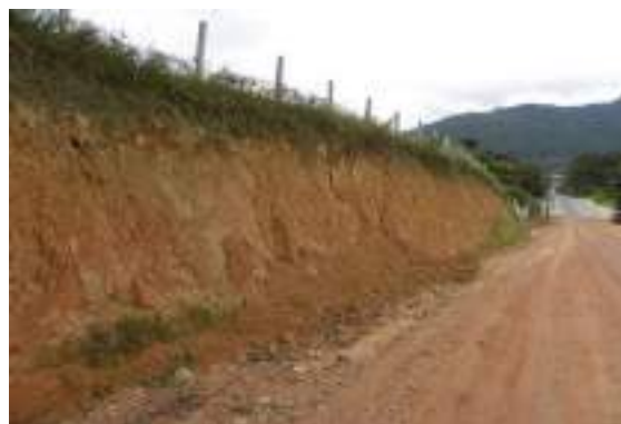
Foto 10.1-21: Detalhe de cambissolo háplico, observado em talude de corte, com presença de horizonte A cascalhento, sobreposto a um horizonte R de textura argilosa; observados no perímetro urbano de Timbó/SC. Coord.: 22 J 667646 m E 7031780 m S.
