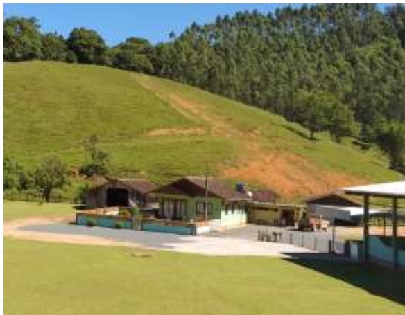
Foto 10.1-58: Unidade habitacional localizada no Bairro Arraial do Ouro, Município Gaspar.
