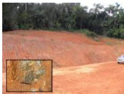
Foto 10.1-5: Talude de corte com exposição de rocha saprolítica, de coloração rósea-avermelhada, de granulação média, correlacionada a saprólito de rocha gnáissica (ver no detalhe) ligada aos Ortognaisses Granulíticos Luis Alves, presente na região de Tatutiva I, município de Blumenau/SC.Coord.: 22 J 691252 m E 7037719 m S
