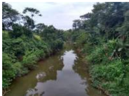
Foto 10.1-66: Rio do Teste em trecho à montante da LT 230 kV Indaial - Gaspar II, no município de Pomerode-SC. Coord.: 22J 682304.34 m E7036672.52 m S.
