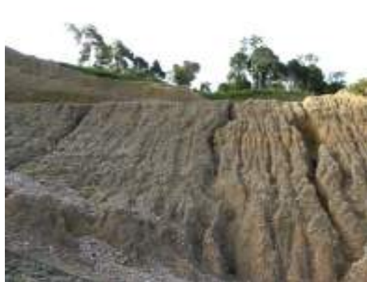
Foto 10.1-56: Caracterização de erosões lineares ao longo da inclinação do talude de corte, sobre paraconglomerados, com presença de sulcos com cerca de 40 cm de profundidade, observado em área de empréstimo no bairro Bela Vista, município de Gaspar/SC. Coord.: 22 J 698255 m E 7023833 m S.
