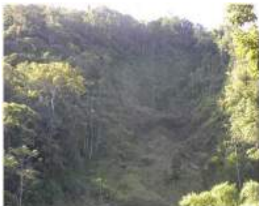
Foto 10.1-57: Coord: Cicatriz de antigo deslizamento observada em uma encosta íngreme, correlacionada ao padrão de relevo serrano, mobilizando solo e rocha superficial. Observar a declividade natural do terreno (45%) neste registro na região de Belchior Alto, município de Gaspar/SC. Coord.: 22 J 701656 m E 7026029 m S.
