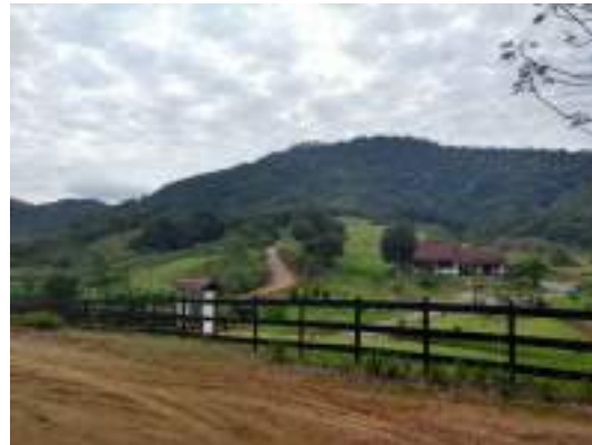
Foto 10.1-76: Eixo da LT 230 kV Indaial – Gaspar II sobre o Ribeirão Vale do Selke, no município de Pomerode. Coord.: 22J 685385.37 m E 7036995.09 m S.
