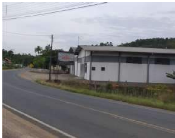
Foto 10.1-71: Infraestrutura existente no bairro Rodeio 12, município de Rodeio.
