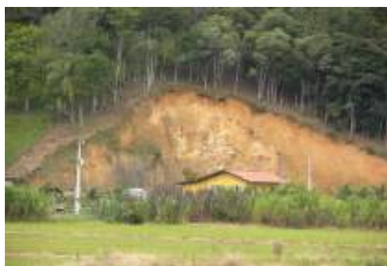
Foto 10.1-22: Exposição de cambissolo háplico em talude de corte, associado à unidade de morrotes e morros baixos, com encosta inclinada entre 10-15%, expostos à erosão por ação pluvial, observado na região de Ribeirão São Paulo, zona rural de Ascurra/SC. Coord.: 22 J 657623 m E 7017070 m S.
