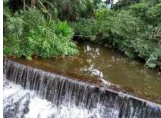
Foto 10.1-62: Ribeirão São Paulo. Interceptado pela LT 230 kV Rio do Sul – Indaial, no município de Ascurra-SC. Coord.: 22J 658185.43 m E7017378.44 m S.
