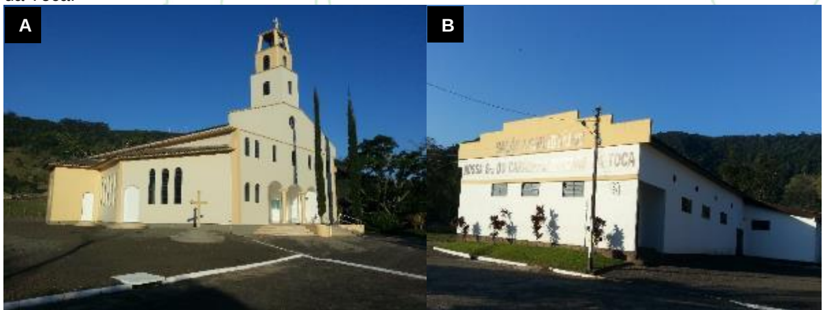
Figura 198 - A) Igreja de Nossa Senhora do Caravággio. B) Salão de festas na comunidade de Espigão da Toca.
