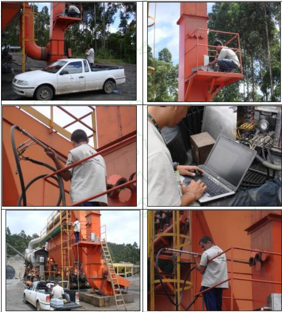
Figura 208 - Amostragem de SO x e materiais particulados, na chaminé da usina de asfalto em Rio Maior.
