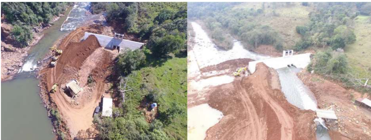
Figura 3.3: Desvio do rio primeira e segunda fase. Fonte: Construnível, 2020.
