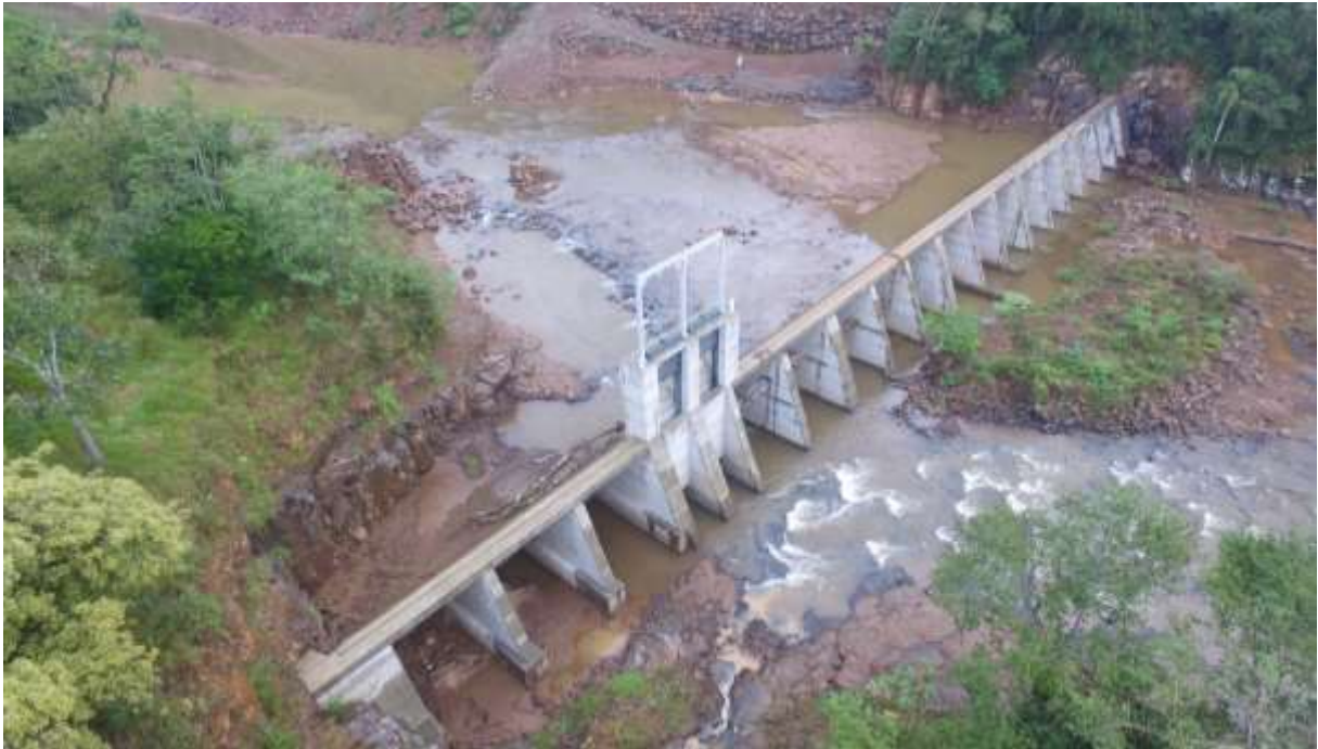
Figura 3.2: Exemplo de barramento em contraforte.
