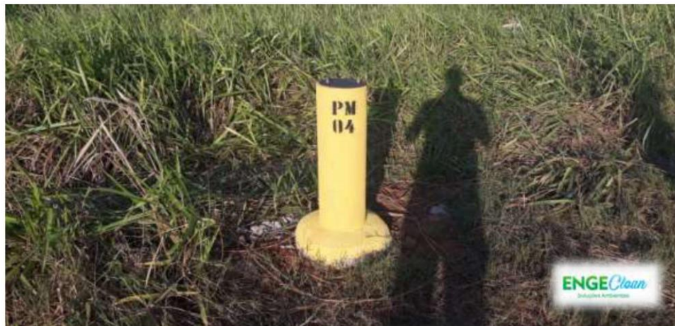
Figura 10: Poço de monitoramento PM 04
