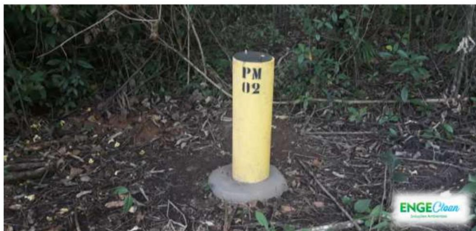
Figura 08: Poço de monitoramento PM 02
