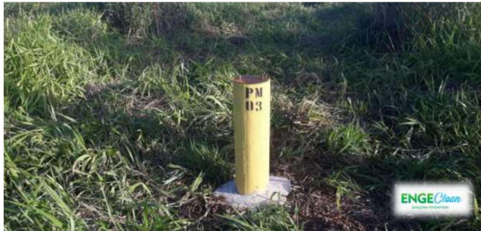
Figura 09: Poço de monitoramento PM 03
