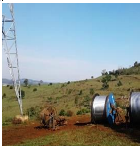
Exemplo de praça de lançamento de cabos.
