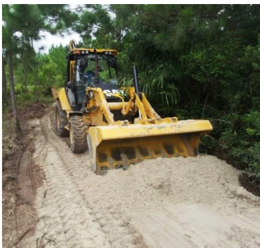
Deposição de material para ajuste de acesso.
