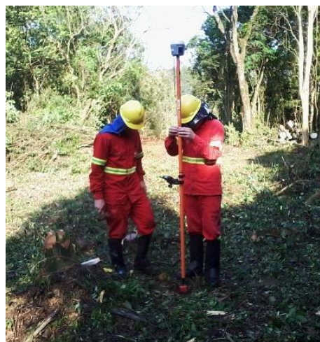
Locação de eixo central em LT.
