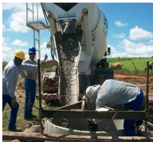
Exemplo de execução de fundações em praça de torre.
