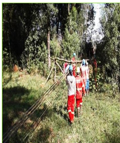
Vista de atividade de lançamento de cabos em travessias de cercas e vegetação.
