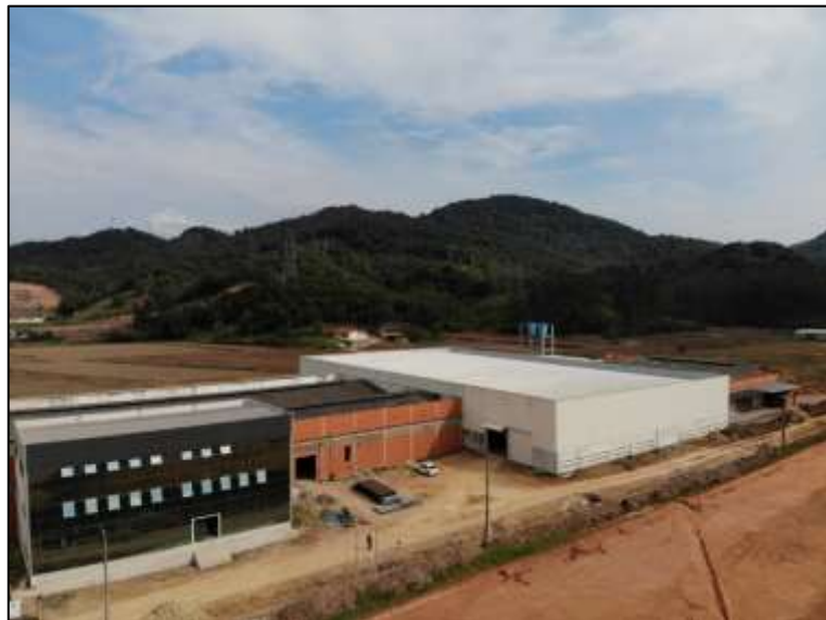
Figura 239: Imagem do entorno, lotes vizinhos ao empreendimento.
