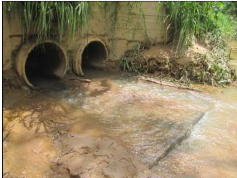
Figura 50: Ribeirão Belchior, ponto de emissão da drenagem pluvial.
