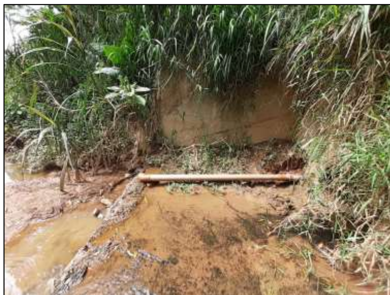
Figura 27: Local de lançamento do efluente industrial da ETE no Ribeirão Belchior.
