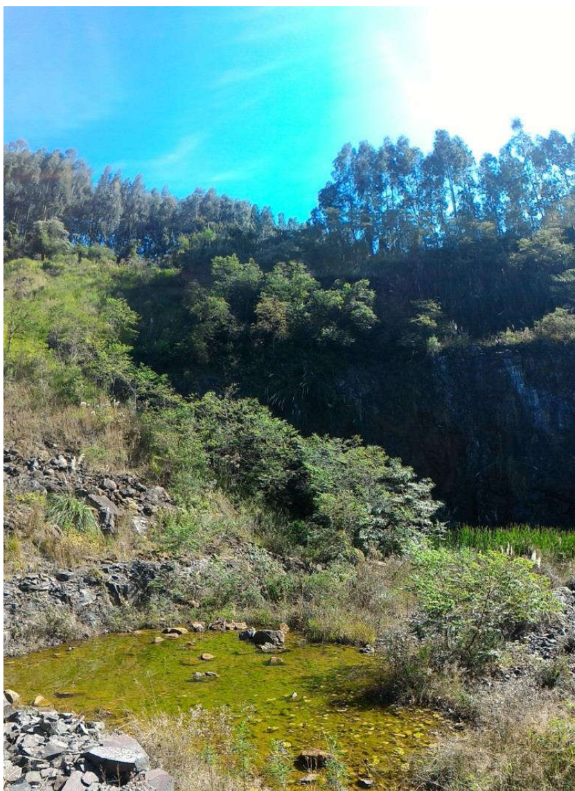
FIGURA 318: Acúmulo de água que brota no talude adjacente no ponto 3.
