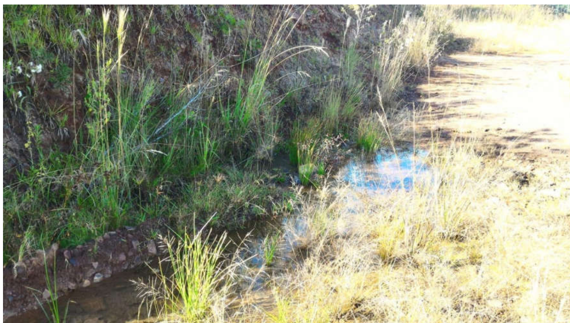
FIGURA 314: Acúmulo de água observado no Ponto 1, junto ao corte do talude.
