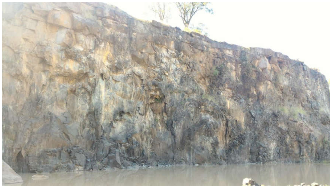
FIGURA 304: Vista geral da face SSE da frente de lavra evidenciando as fraturas horizontais limitadas ao topo da lavra.
