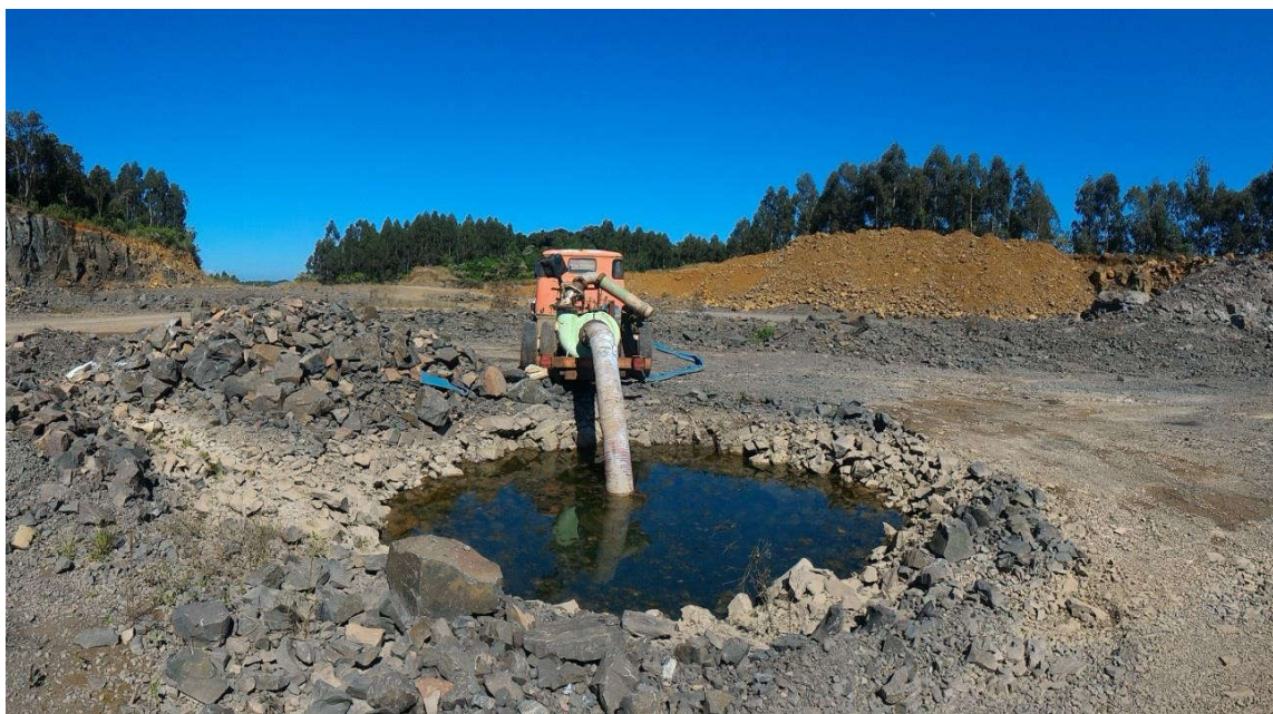
FIGURA 321 Poço escavado utilizado para as atividades da lavra.
