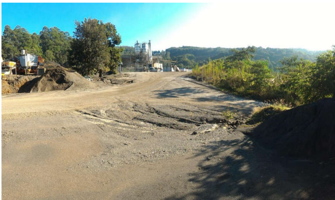
FIGURA 306: Vista panorâmica da estrada de acesso a lavra evidenciando processos erosivos em sulcos no centro da foto, na lateral da estrada e erosão laminar na estrada.
