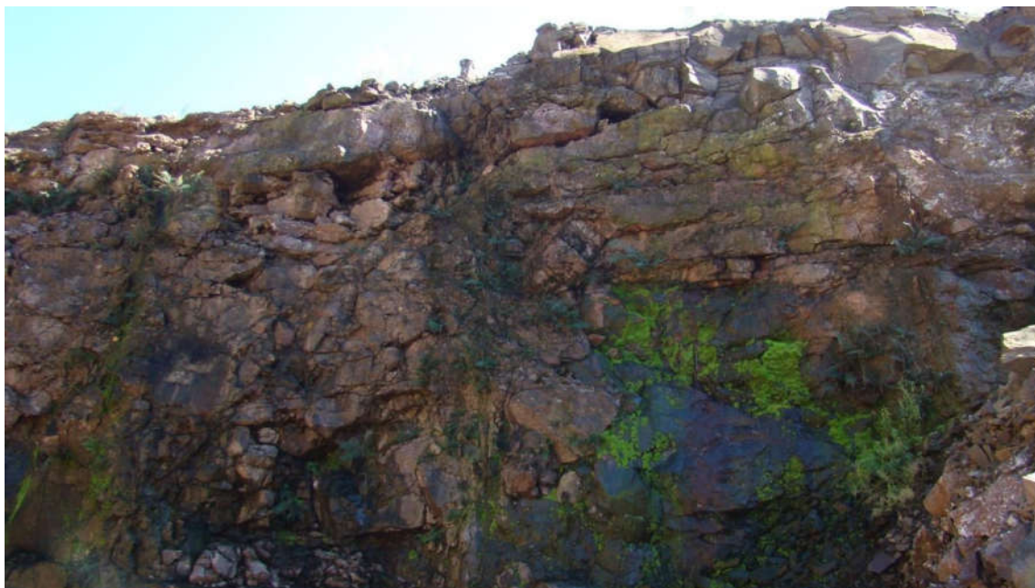
FIGURA 308: Fraturas sub-horizontais no topo da frente de lavra. Descontinuidades que produzem blocos susceptíveis a movimentação, se ocorrer instabilidade do talude.
