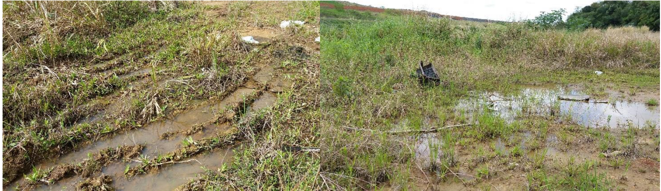
Figura 68: Poças de água temporárias formadas pela presença de veículos automotores na área de estudo (a) e acúmulo de água pluvial com presença de depósito de lixo (b).
