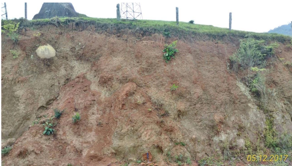
Figura 11.1-37 – Talude de Corte Subvertical de Estrada Caracterizado por um Perfil de Cambissolo Háplico.
