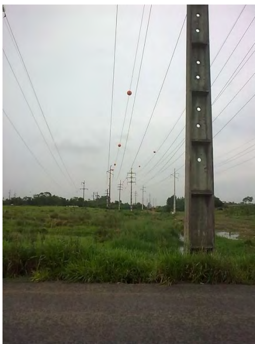
Figura 27: Vista de estruturas de tipo poste em circuito simples e duplo.
