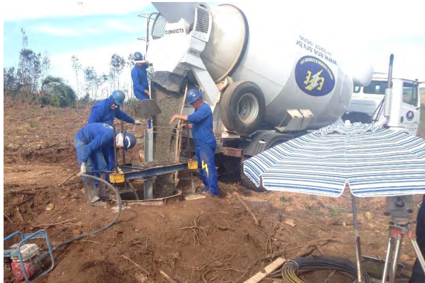
Figura 33: Exemplo de execução de fundações em praça de torre.
