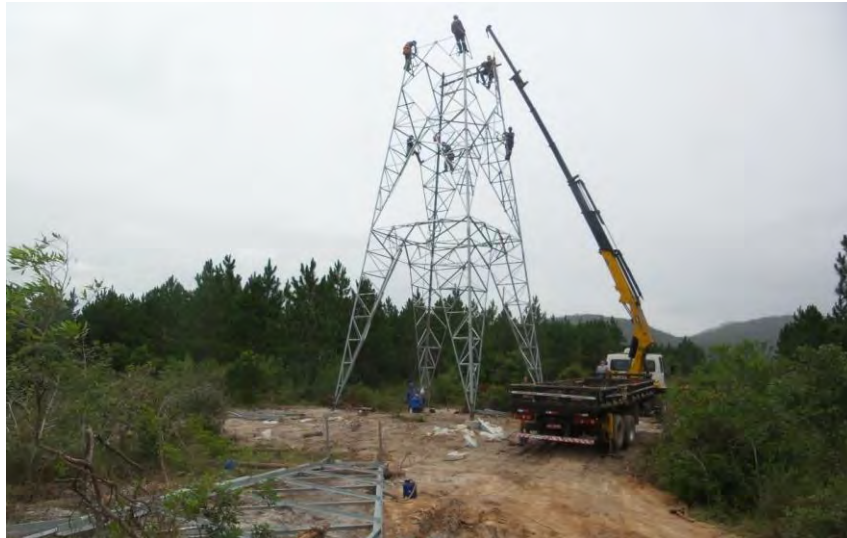
Figura 34: Montagem de torre.
