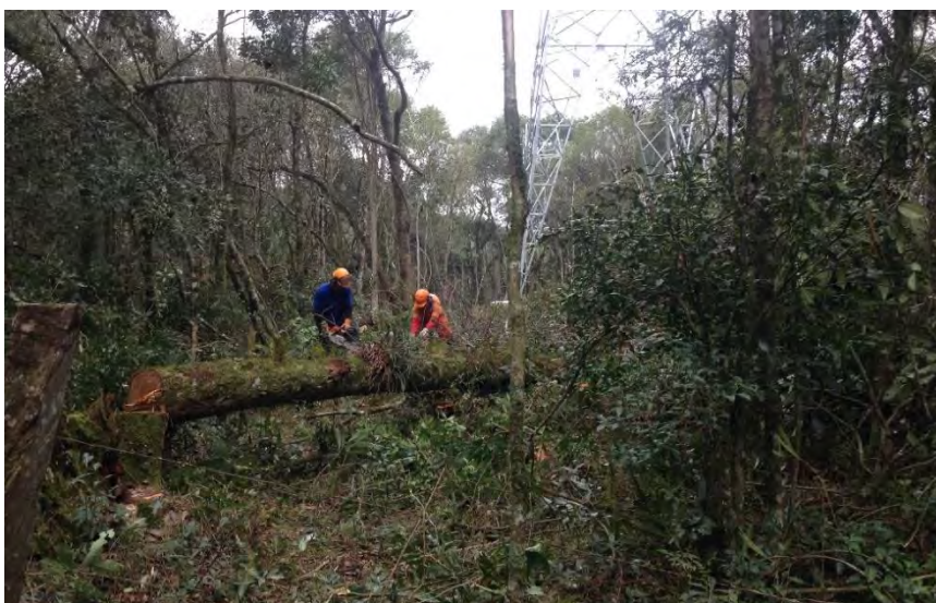
Figura 32: Supressão de vegetação em faixa de 3 metros.
