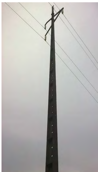
Figura 26: Vista de poste em circuito simples.
