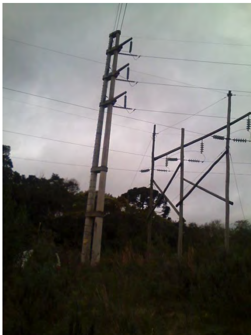
Figura 25: exemplo de estrutura em poste em circuito simples.
