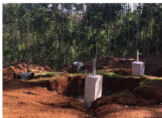
Figura 12: Fundação tipo sapata finalizada.
