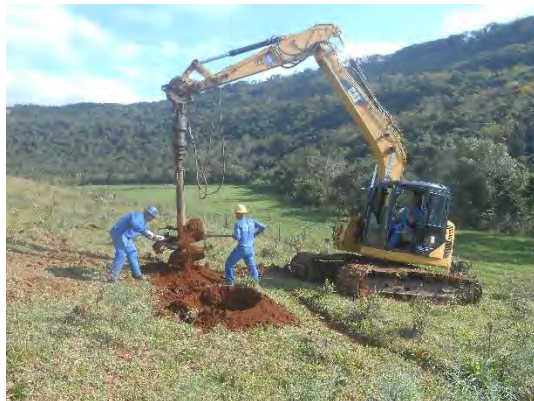
Figura 9: Exemplo de escavação do tipo tubulão.
