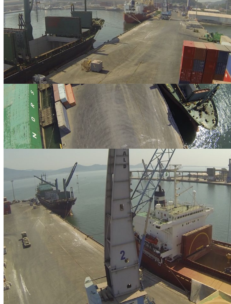
Figura 1. Porto de São Francisco do Sul, Município de São Francisco do Sul, Santa Catarina.
