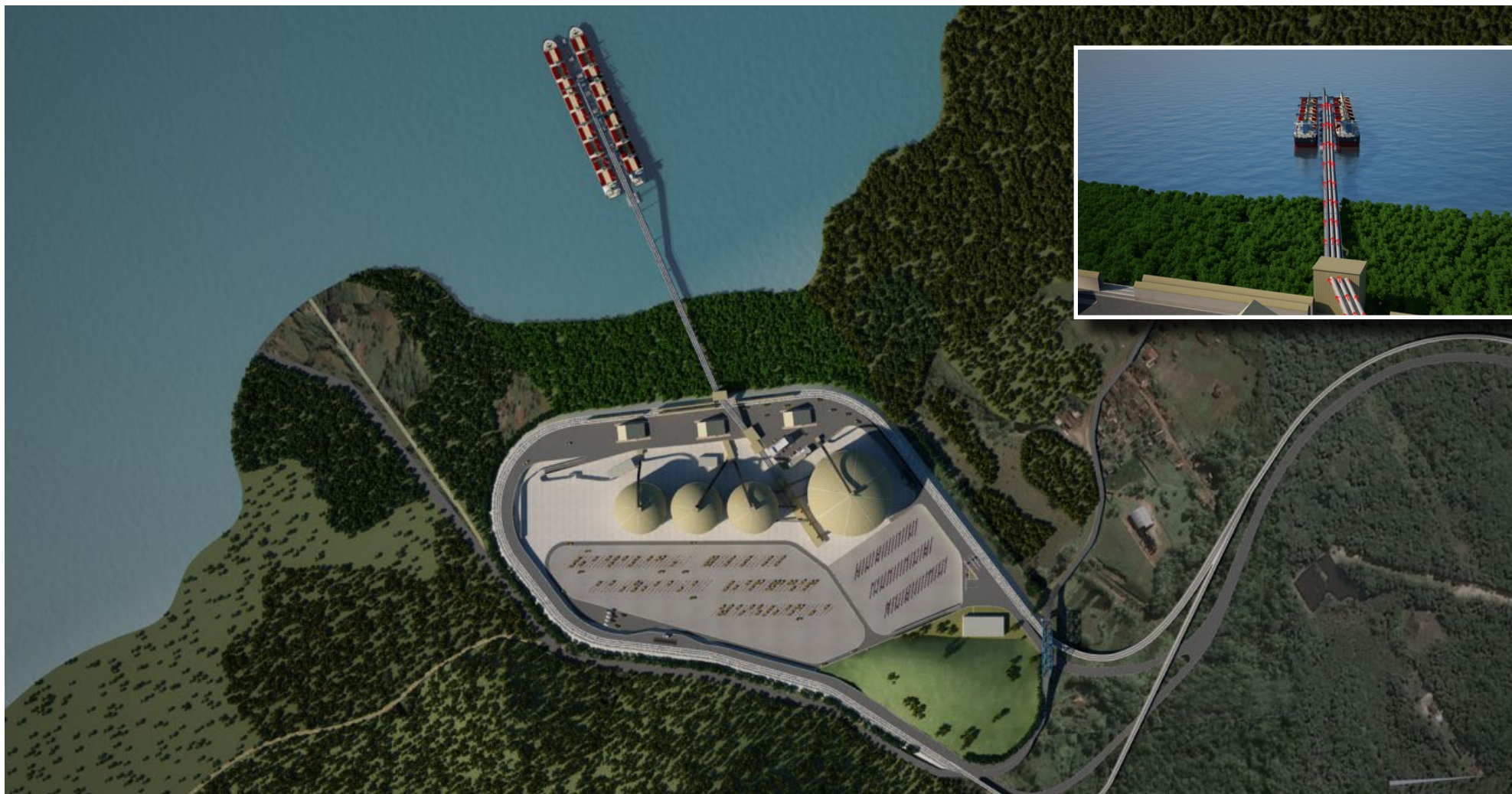
Figura 4. Perspectiva das instalações nas áreas aquática e terrestre do Terminal Graneleiro da Babitonga – TGB.
