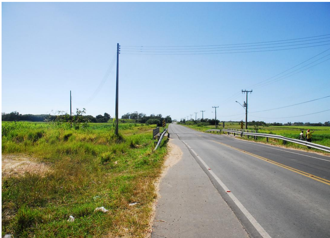
Figura 5.126 - SC 442 – Principal via de acesso a área do empreendimento
