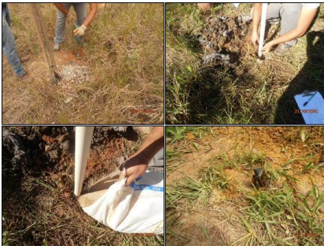
Figura 158. Escavação do solo com trado manual, colocação da coluna do poço (tubo de PVC). PZ-01, preenchimento do espaço anelar do poço na profundidade da camada de entrada de água com areia de pré-filtro, determinação das coordenadas dos poços piezométricos com GPS de navegação. Fonte: Diretrizes Ambiental – 2017.
