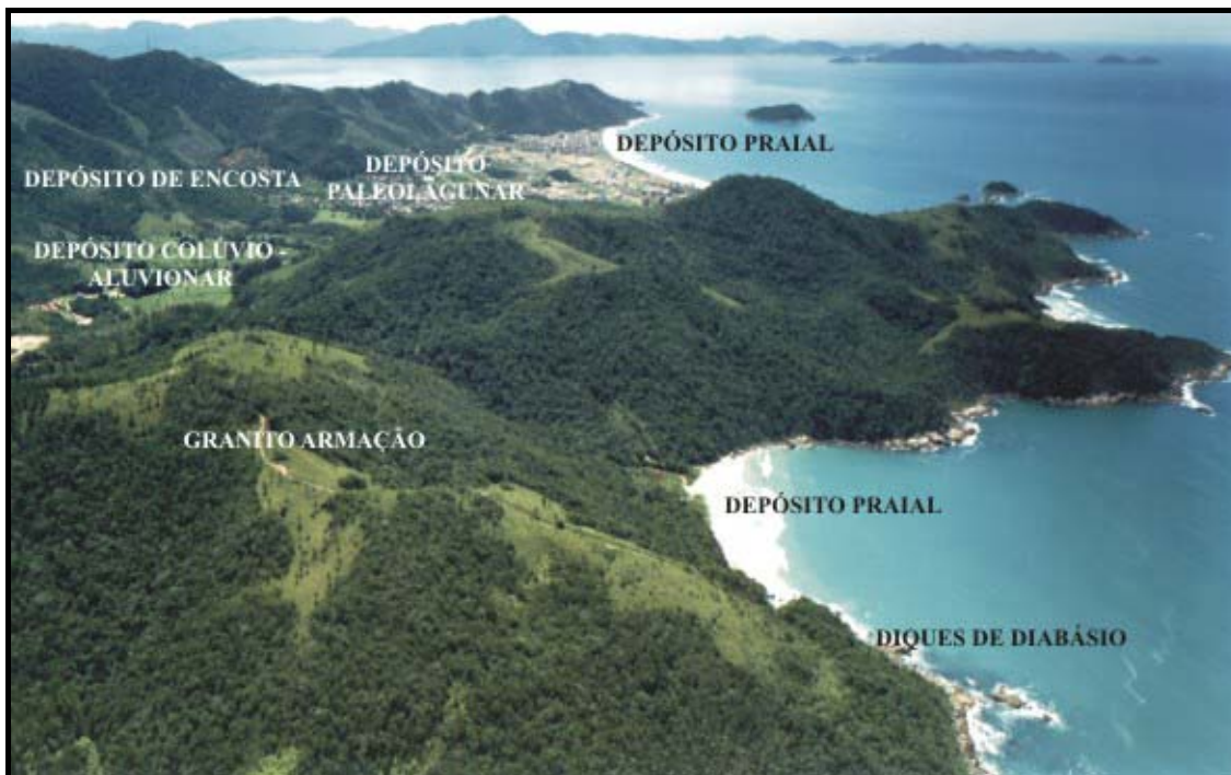
Figura 30. Vista panorâmica da área de influência direta do empreendimento, com a indicação das principais formações geológicas aí presentes.
