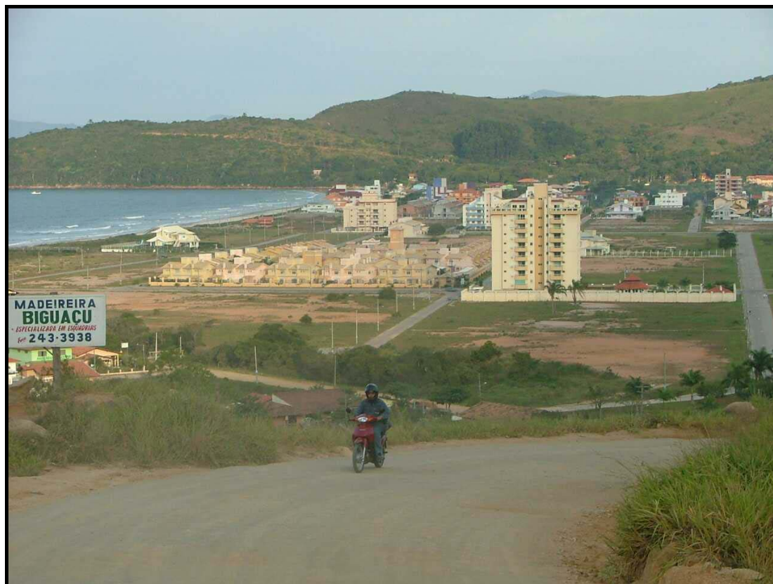
Figura 39. Trecho da rodovia SC-410 sem pavimentação, nas imediações do balneário e Palmas.
