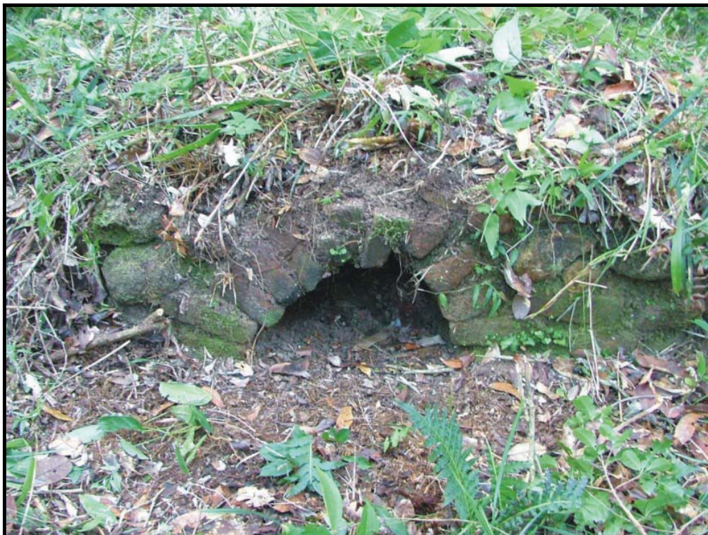
Figura 108. Detalhe da boca do forno.
