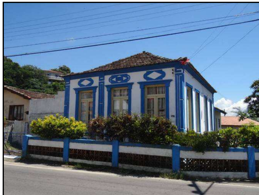
Figura 90. Edificação com características do período de colonização açoriana, município de Governador Celso Ramos. Fotos: CARUSO JR, 2012.
