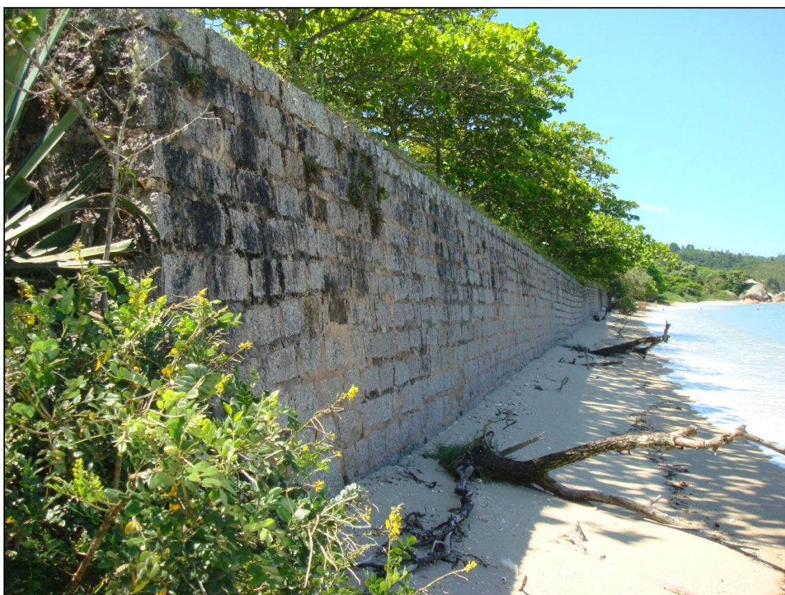
Figura 22: Muro de contenção de maré.
