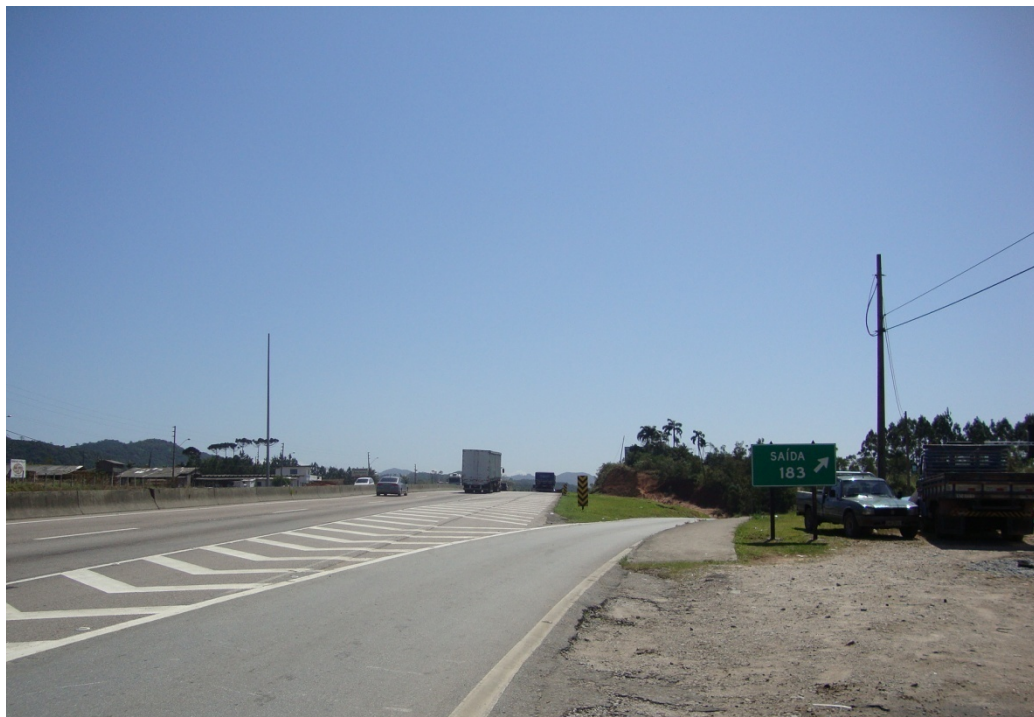
Figura 118: Trecho da BR 101 com acesso a rodovia SC 410
