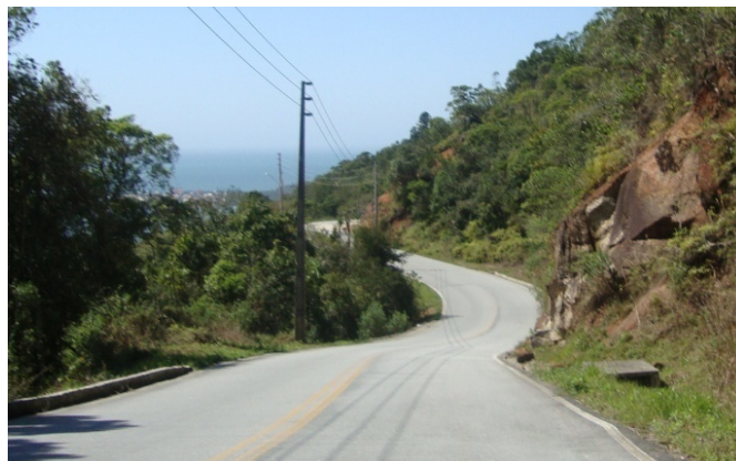
Figura 122: Trecho ondulado na rodovias GCR 120
