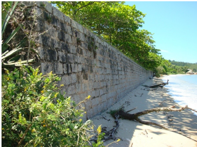
Figura 63: Muro de contenção ao longo da faixa de areia.
