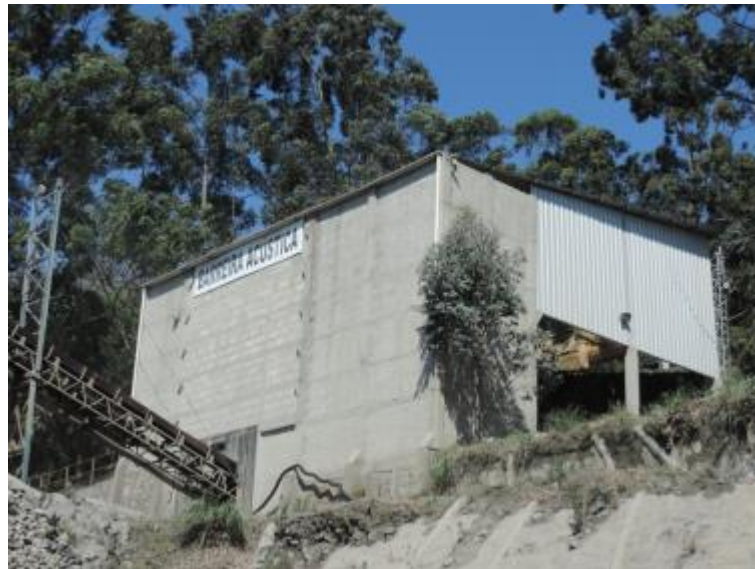
Figura 6-19 - Construção da barreira acústica no britador primário. Fonte: do autor.
