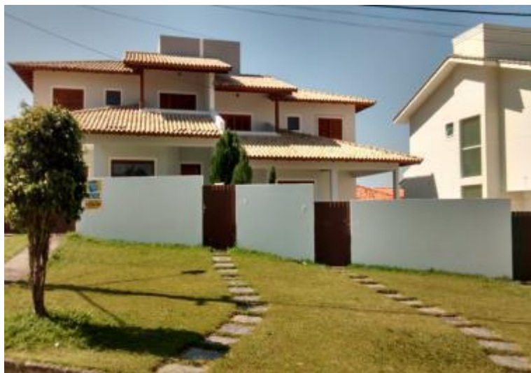
Figura 6-158 - Residência de alto padrão construtivo. Fonte: do autor.
