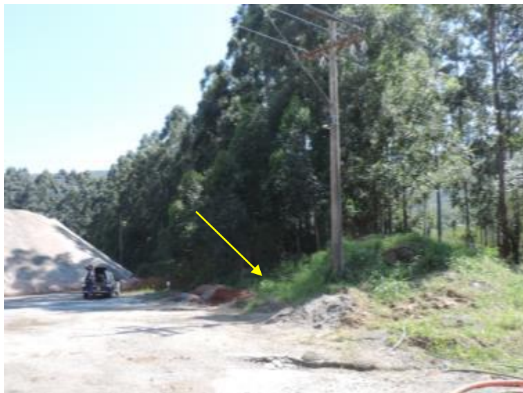
Figura 6-18 - Localização da barreira de terra construídas pela empresa. Fonte: do autor.
