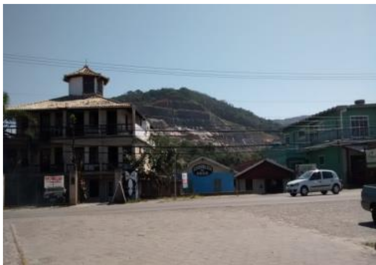
Figura 6-156 - Imóveis de uso misto comercial e residencial no bairro Rio Tavares. Ao fundo vê-se a lavra da empresa Pedrita Planejamento e Construção Ltda.
