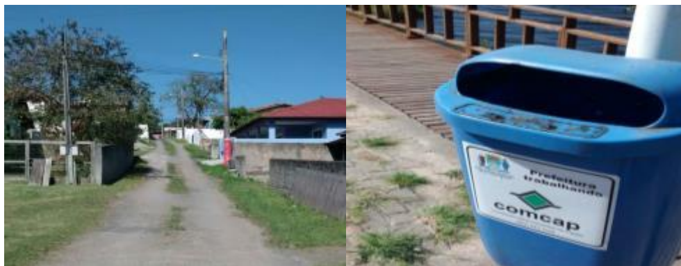
Figura 6-165 - A esquerda, inexistência de rede pluvial e de captura de esgoto doméstico nas esquinas das Servidões Amantino Cameu e Maria Ana Cameu. A direita, lixeira da COMCAP próximo na Avenida Campeche, ao lado da Lagoa Pequena. Fonte: do autor.
