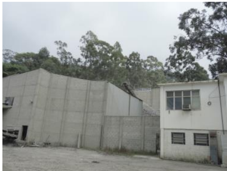
Figura 6-20 - Construção da barreira acústica nos rebitadores. Fonte: do autor.
