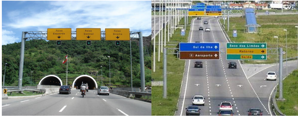
Figura 6-79 - O acesso do centro do município para ao sul da ilha pode ser feito pelo túnel e pela Via Expressa Sul.
