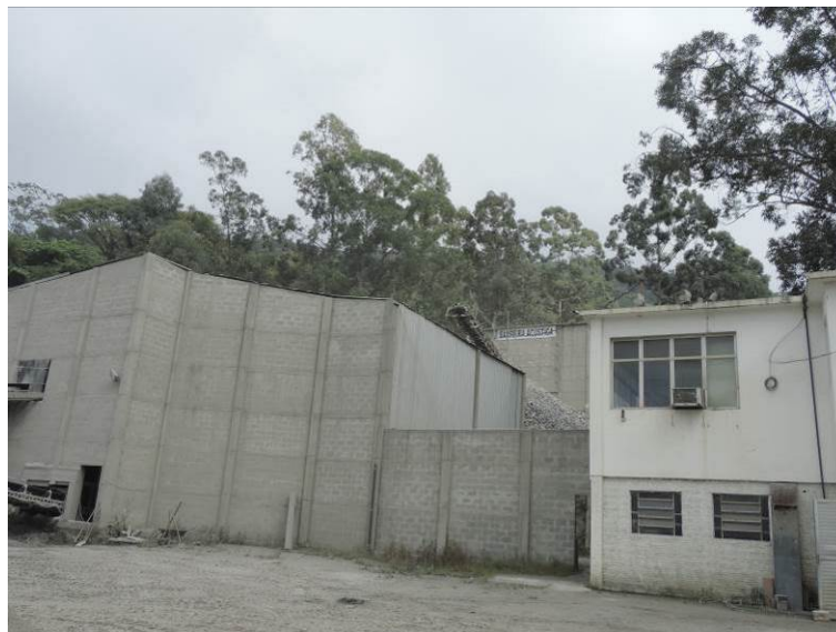
Figura 6-15 - Construção da barreira acústica nos rebitadores. Fonte: do autor.
