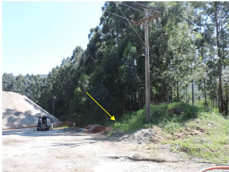
Figura 6-13 - Localização da barreira de terra construídas pela empresa. Fonte: do autor.
