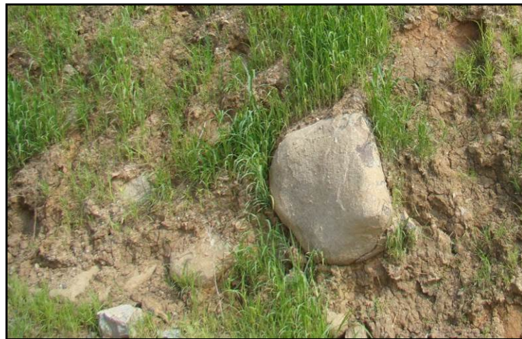
Figura 6-21 - Depósitos coluvial constituído de argilas, areias, blocos e matacões de rocha granítica. Fonte: do autor.
