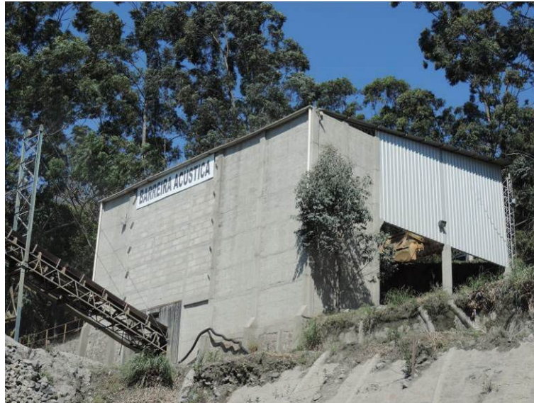
Figura 6-14 - Construção da barreira acústica no britador primário. Fonte: do autor.
