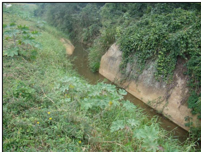
Figura 6-25 - O rio Tavares encontra-se ainda encaixado no maciço granítico, na porção leste do compartimento fluvial. Fonte: do autor.
