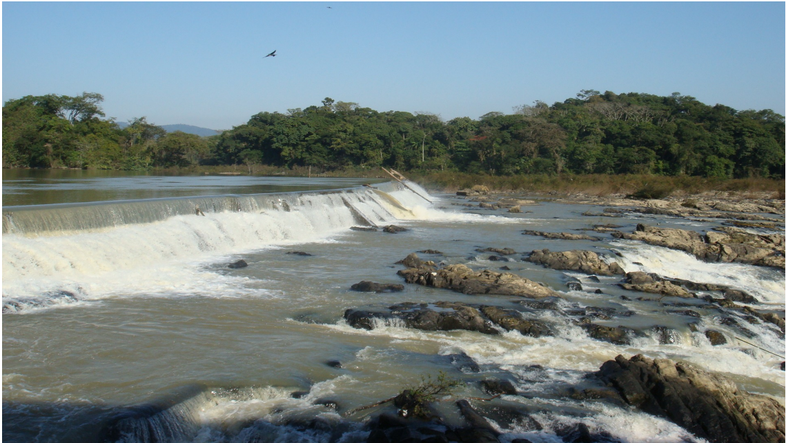
Figura 3.6 - Vista do Barramento 1 mais próximo da Casa de Força existente.
