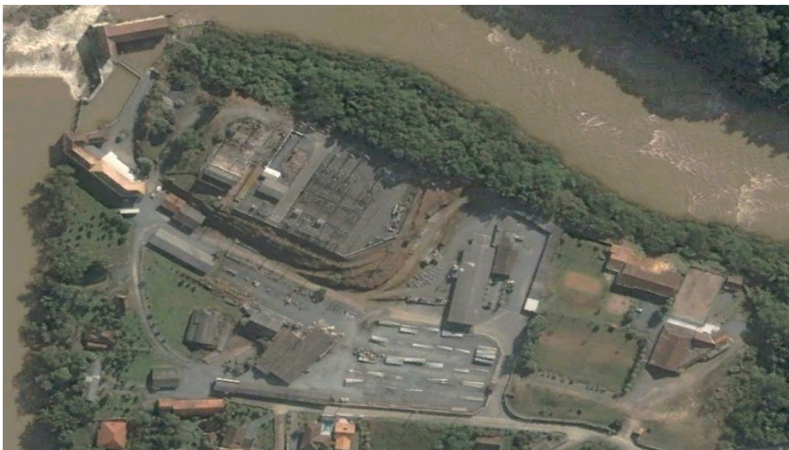
Figura 3.2 - Vista aérea da Usina PCH Salto.
