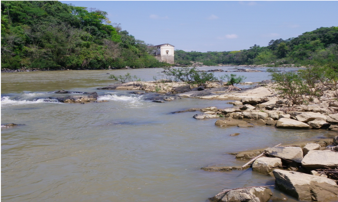
Figura 3.1 - Vista à jusante do rio Itajaí-Açu com casa de força atual ao fundo.
