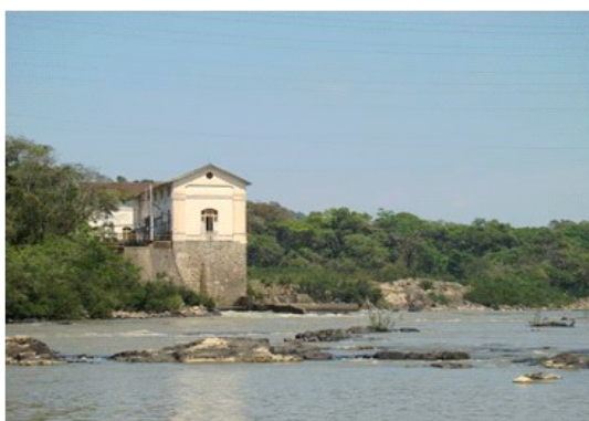
Figura 6.24 - Casa de força da PCH Salto e o trecho do Itajaí-Açu imediatamente a jusante.
