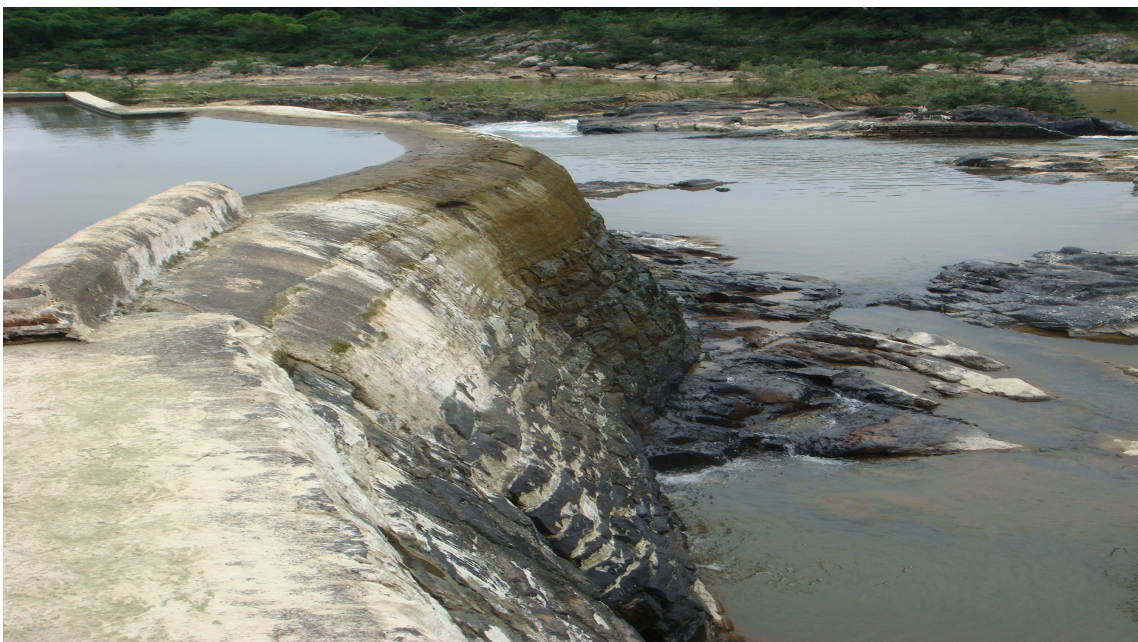
Figura 3.5 - Vista do Barramento 1 – Perfil da soleira vertente atual.
