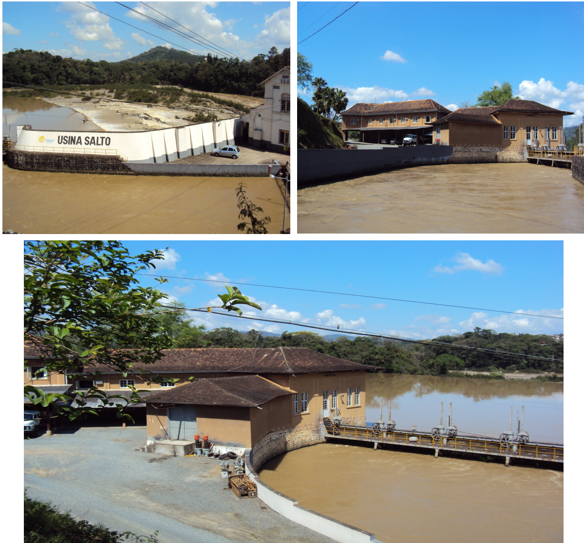
Figura 3.4 - Estrutura atual da PCH Salto.
