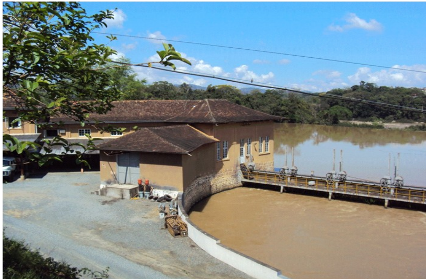
Figura 6.17 - Captação de água do rio Itajaí-Açu para geração de energia junto à da PCH Salto.
