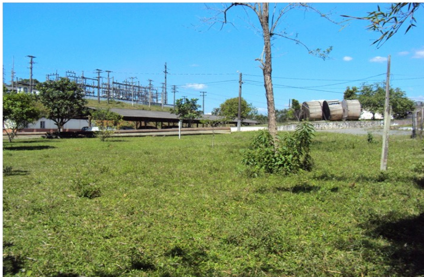
Figura 6.8 - Porção noroeste da área da PCH Salto, com relevo plano, e detalhe do alto topográfico ao fundo.
