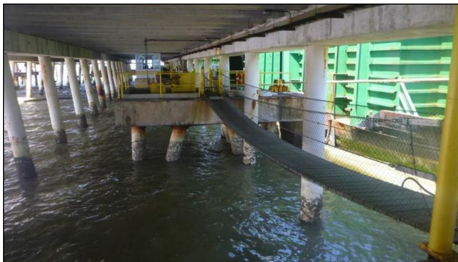
Figura 756. Estacas metálicas demonstrando incrustação de moluscos.
