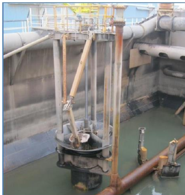
Figura 745. Sistema de overflow regulável em posição baixa.
