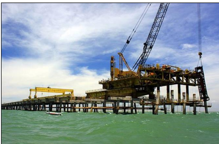
Figura 33. Método construtivo de estaqueamento tipo "cant traveller".
