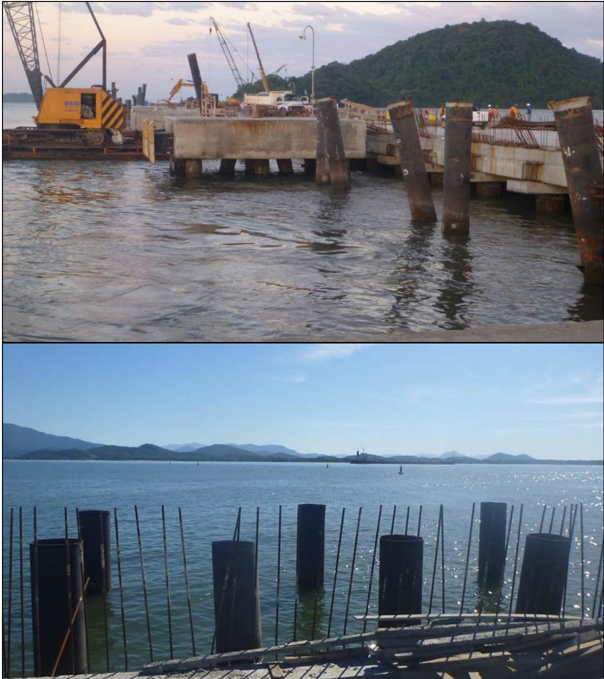
Figura 29. Tipo de estacas metálicas tubulares preenchidas com concreto.
