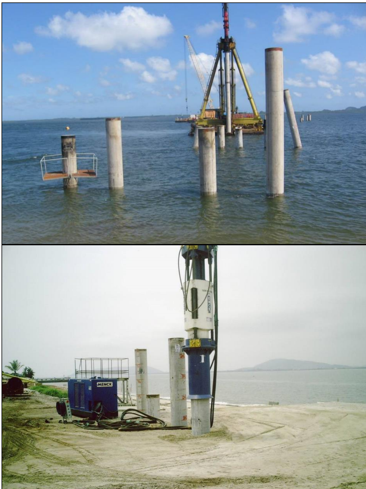
Figura 30. Estacas de concreto pré-moldado cravadas em mar (plano superior) e terra (plano inferior).
