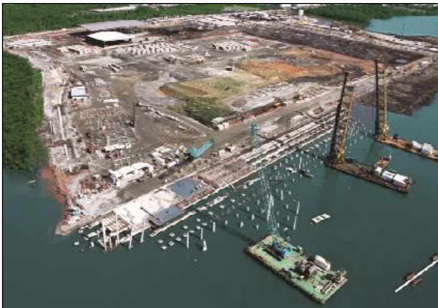
Figura 32. Exemplo dos métodos construtivos de bate estaca sobre flutuantes.
