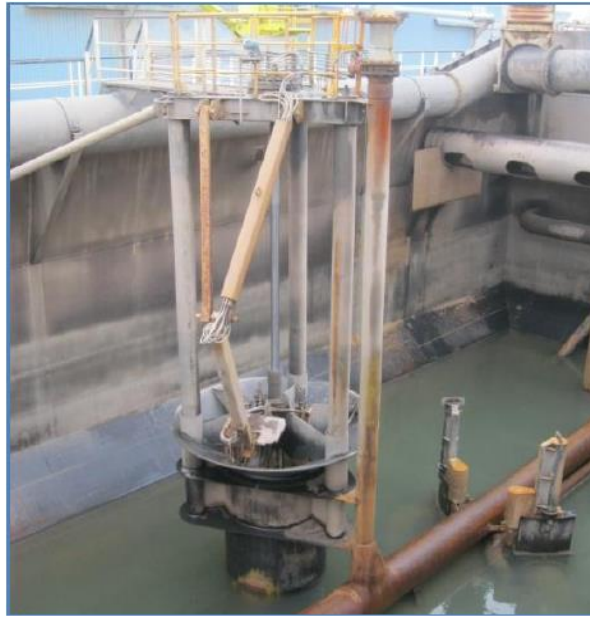
Figura 758. Sistema de overflow regulável em posição baixa.
