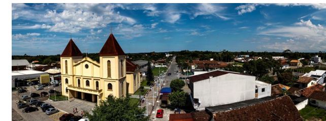
Área central do município de Araquari, com ocupação horizontal. Foto: Araquari, 2014.
