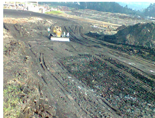
Aterro de resíduos Geoklock
