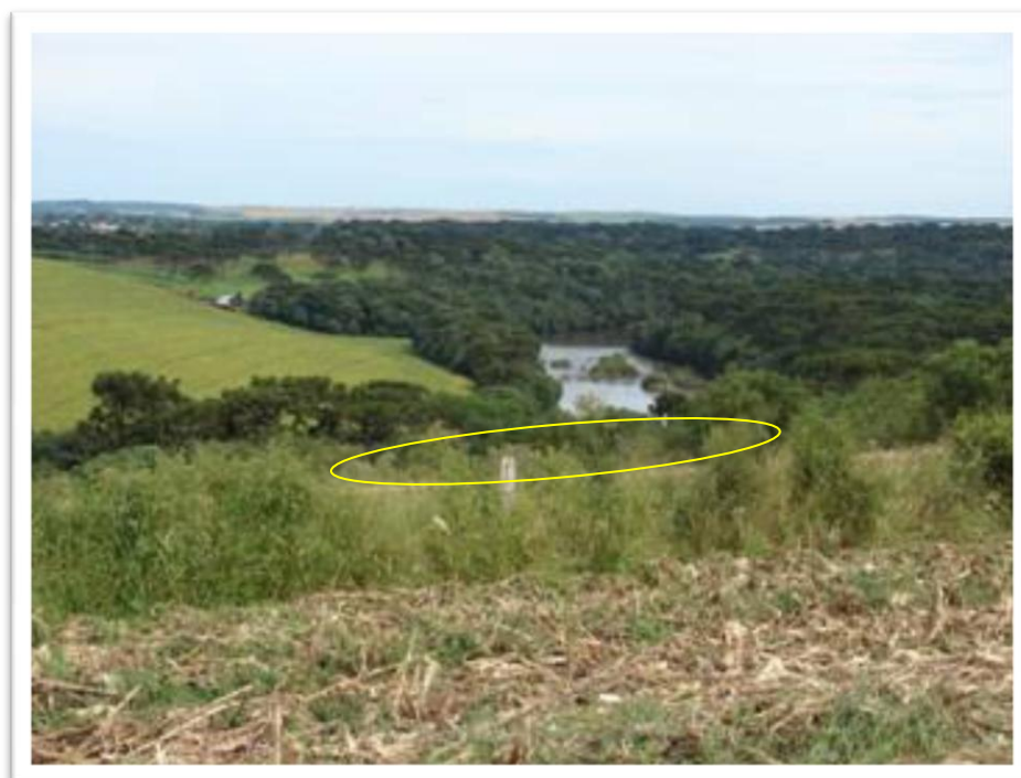
Figura 20 - Foto da área onde será instalada a casa de força, com destaque para o local da implantação.
