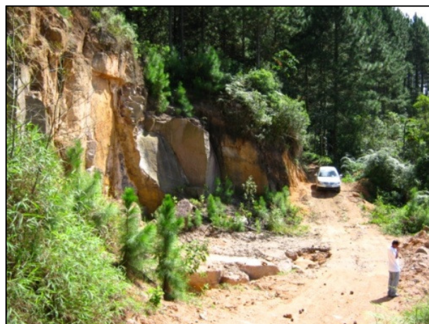
Figura 3.1-III: Extração abandonada na margem esquerda do rio com cicatriz de escorregamento
