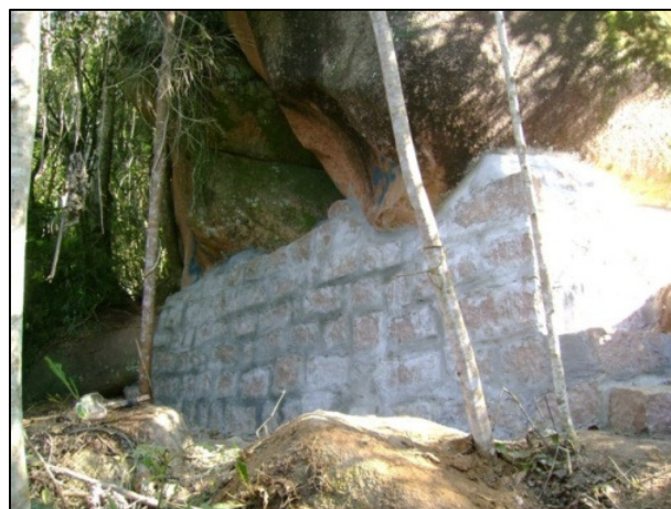
Figura 3.2-VI: Estabilização de matacões com muro de blocos de rocha na comunidade Subida
