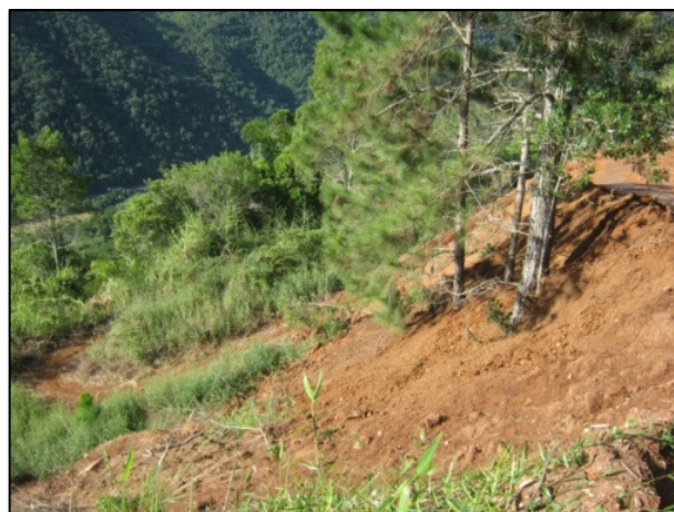
Figura 3.2-II: Movimentação de terra formando patamares de aterros para acessos. Detalhe da inclinação do terreno
