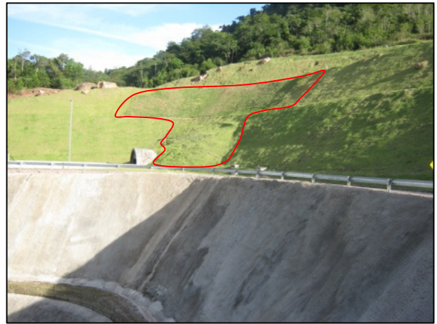
Figura 3.2-VIII: Área de antigo escorregamento ocorrido no pátio da UHE, acima da saída d'água
